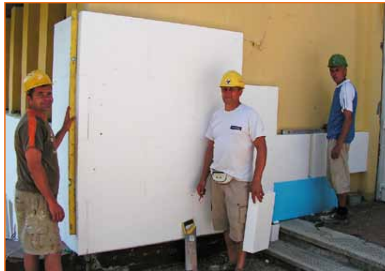
A „Tiszta Hallás” Bt. dolgozói (balról jobbra haladva) Maginyecz János, Janecskó András és Zentai Lajos az épület falának nikecelles borítását végzik
